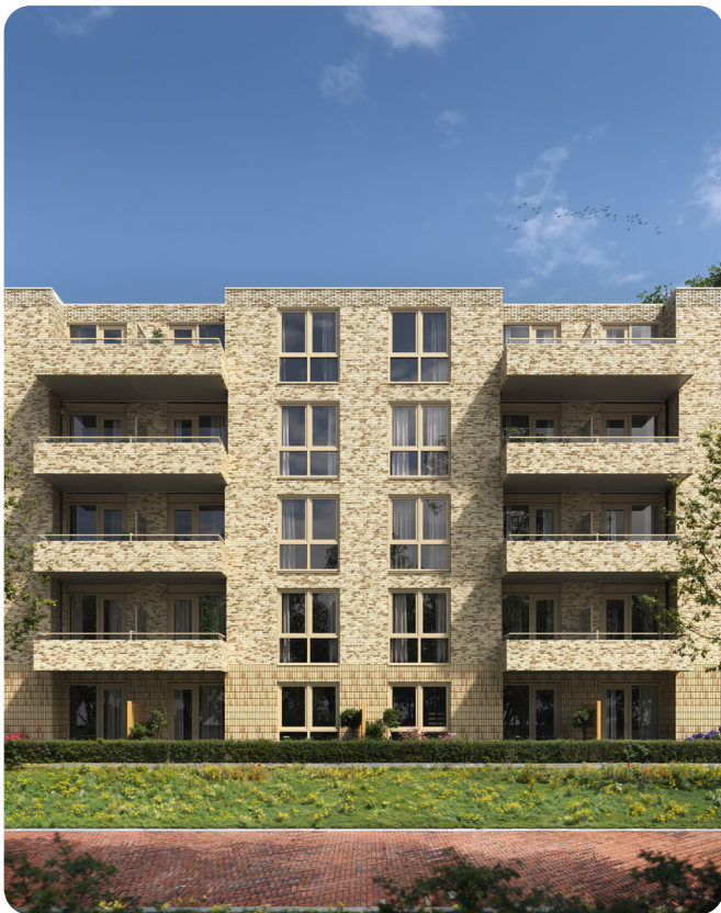
Optie - Half inpandig gemetselde borstwering
